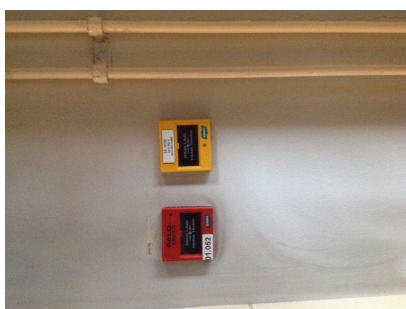
Palohälytyksenlaukaisu sekä ilmanvaihdon hätäseis
