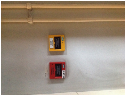
Palohälytyksenlaukaisu sekä ilmanvaihdon hätäseis
