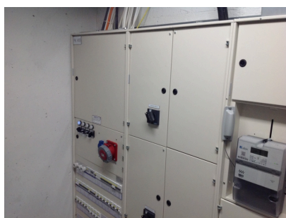
Sähköpääkeskuksen laitteisto
