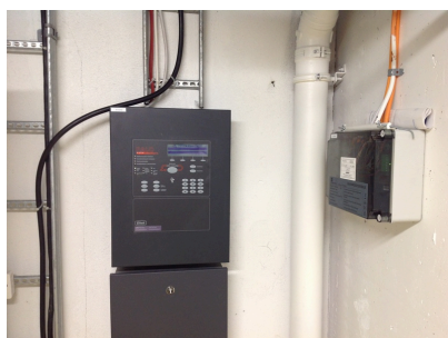
Palovaroitinkeskus ja savunpoistokeskus
