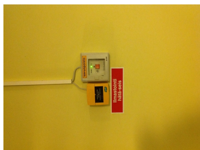
Savunpoistolaitteiston ja ilmanvaihdon laukaisu painikkeet
