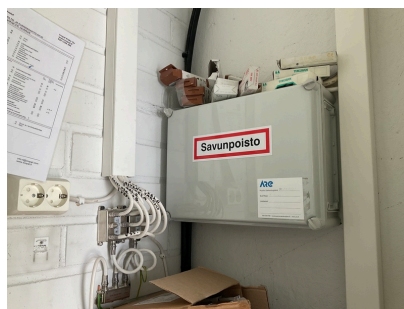
Savunpoistokeskus A-talon sähköpääkeskuksessa
